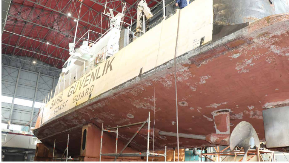
Sahil Güvenlik Botu Havuz Onarımı
