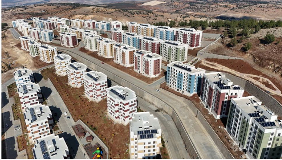
Kilis'te Yapımı Tamamlanan ve Depremzedelere Teslim Edilen Konutlar
