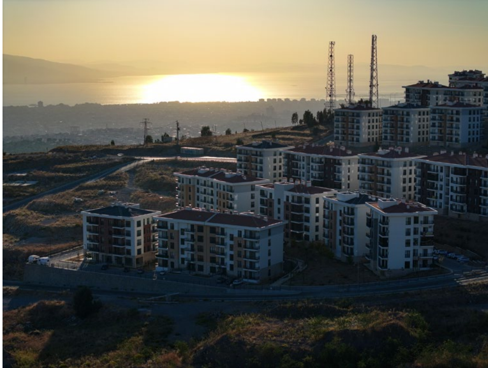
İzmir’de Depremzedelere Teslim Edilen Konutlar
