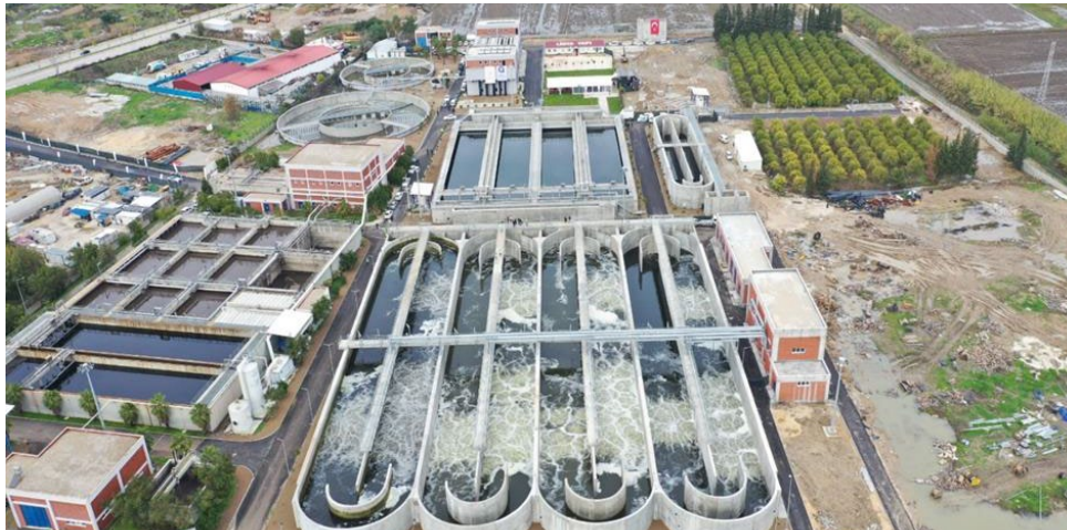
Serik – Atık Su Arıtma Tesisi
