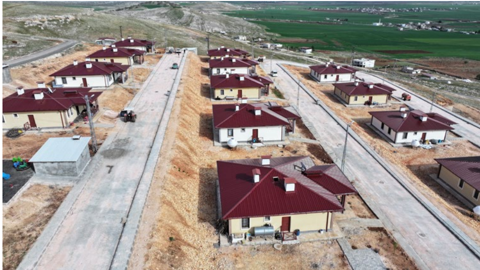
Diyarbakırlı Depremzedeler İçin Hazırlanan Yeni Köy Tipi Konutlar
