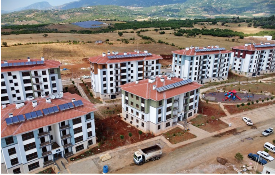
Osmaniye Düziçili Depremzedeler İçin İnşaatı Tamamlanan Konutlar
