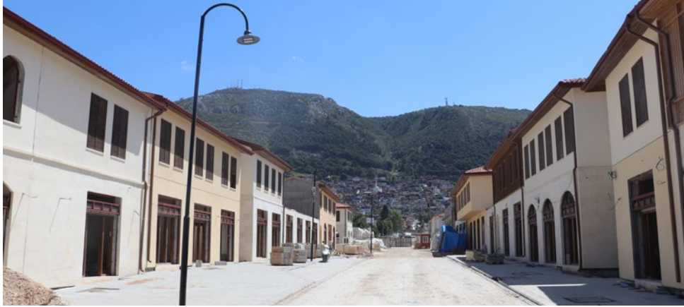
Hatay İl Merkezinde Sürdürülen İş Yeri Yapım Çalışmaları
