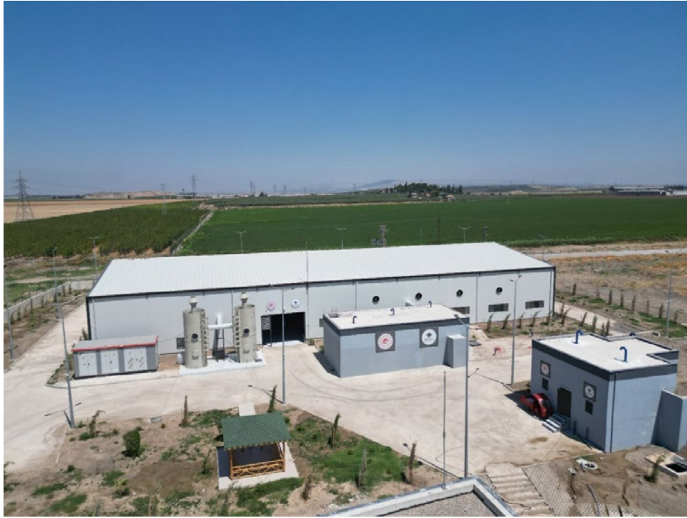
İller Bankası desteğiyle yapımı tamamlanan Hatay Reyhanlı İçme Suyu Arıtma Tesisi
