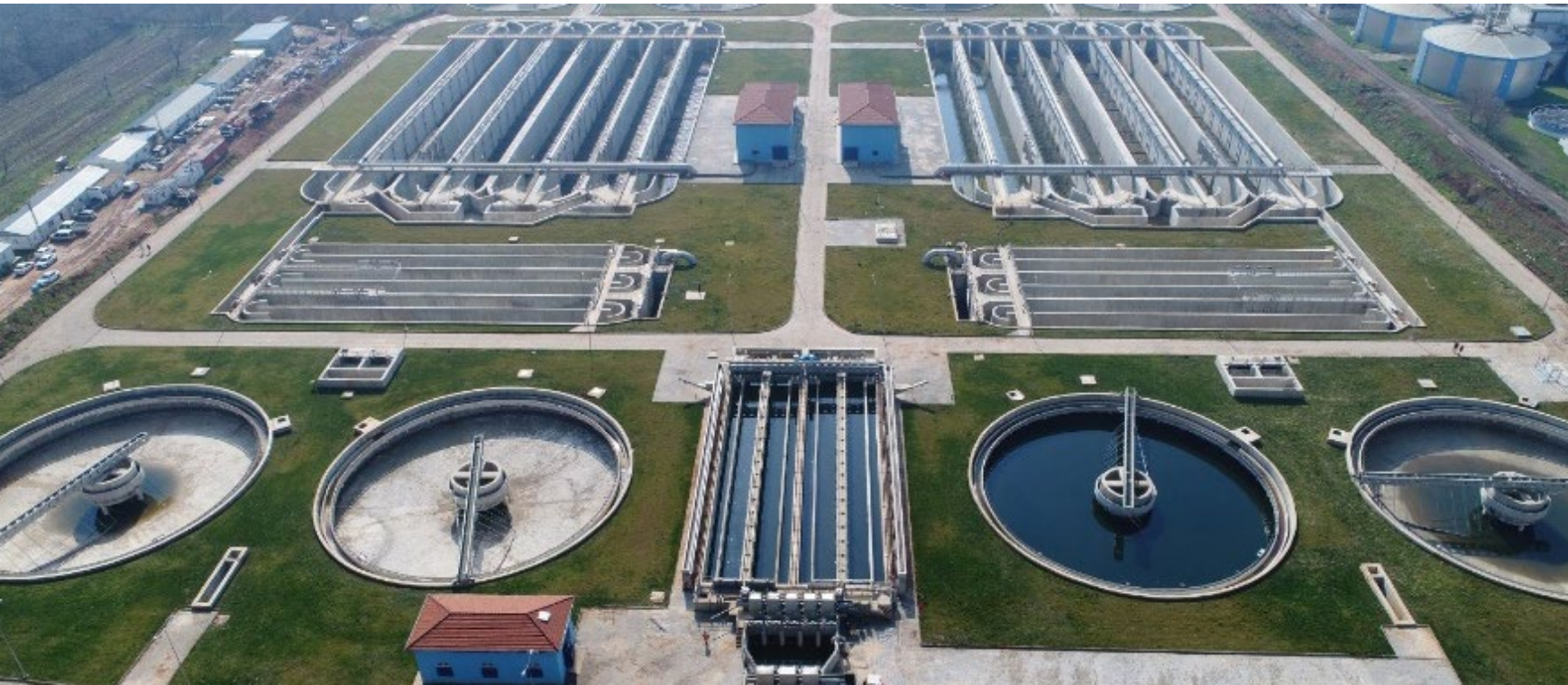
Merkez/Gaziantep Atık Su Arıtma Tesisi
