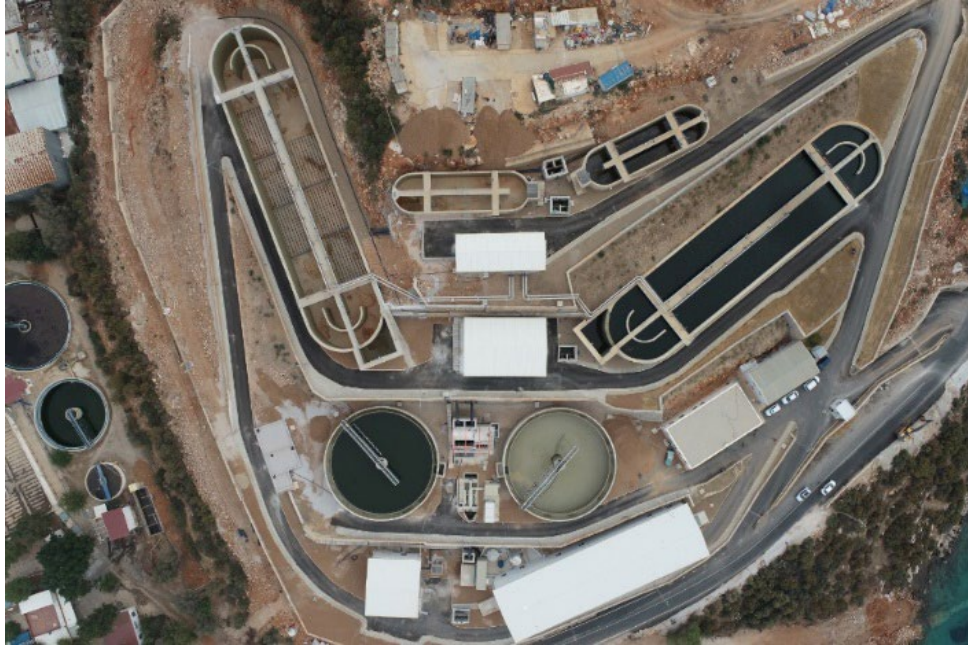
Muğla Bodrum İçmeler - Torba Atık Su Arıtma Tesisi
